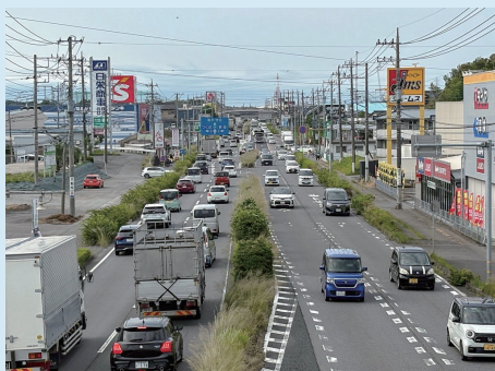
写真：国道294号 つくばみらい市小絹付近
