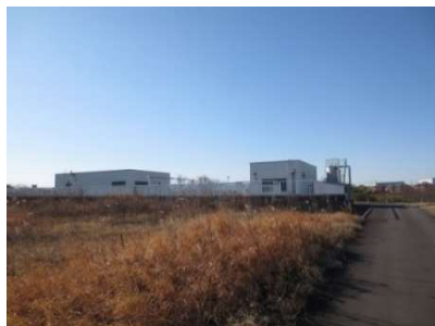
小絹水処理センター水処理棟
