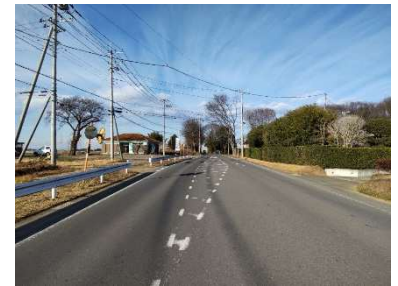
中原線整備事業 （中原・市道拡幅用地費）
