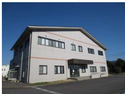
小絹水処理センター管理棟
