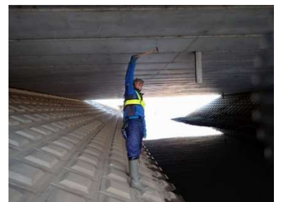
橋梁長寿命化修繕事業 （85橋・橋梁定期点検業務委託料）
