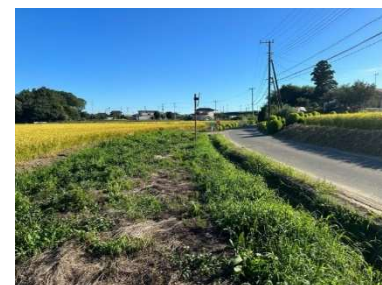
道路安全対策事業 （川崎・通学路安全対策工事）
