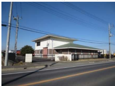
上小目中継ポンプ場
