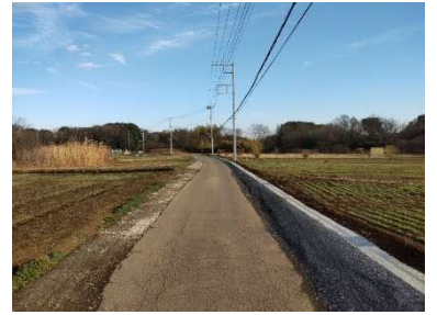
狭あい道路整備等促進事業 （戸茂・道路新設改良工事）
