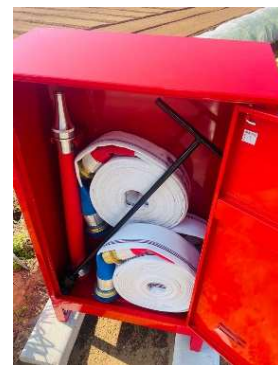
消火栓ホース格納箱取替工事
