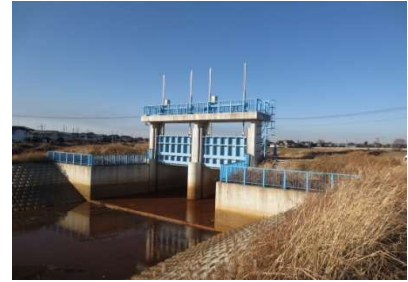
蛇沼排水路樋管
