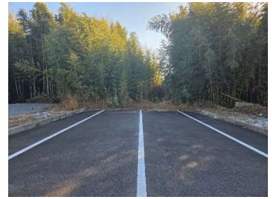
守谷小絹線整備事業 （2工区・道路新設改良工事）
