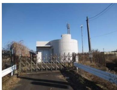
高掛中継ポンプ場
