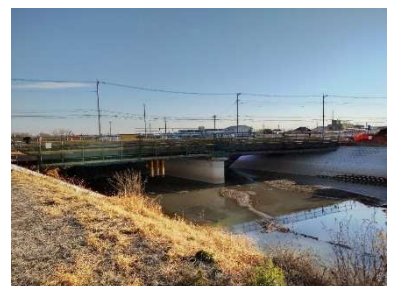
橋梁施設改修事業 （福新橋・橋梁施設改修工事負担金）
