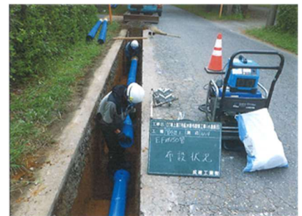
配水管布設替工事
