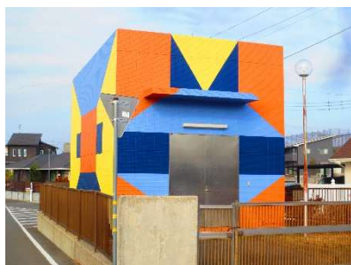
内宿中継ポンプ場
