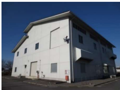
小絹水処理センター汚泥棟
