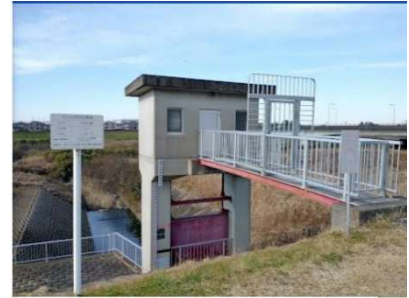
大谷津排水樋管
