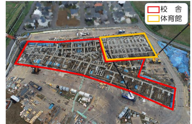
工事現況写真：令和 7 年 10 月末時点
