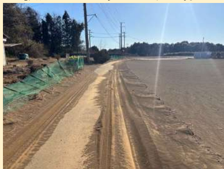
農地の表土が道路に流出した状態
