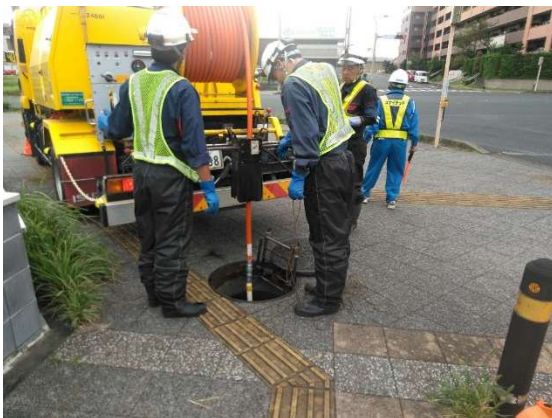
管渠清掃業務（作業中）
