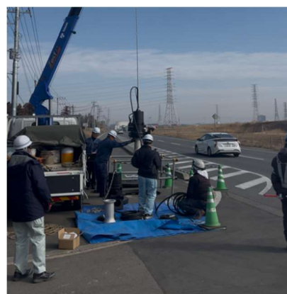
マンホールポンプ設置工事
