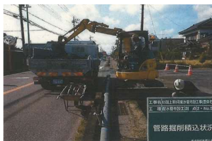
配水管布設工事
