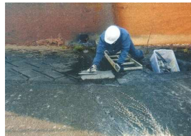
蛇沼排水路補修工事
