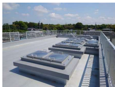
久保浄水場低区配水施設改修
