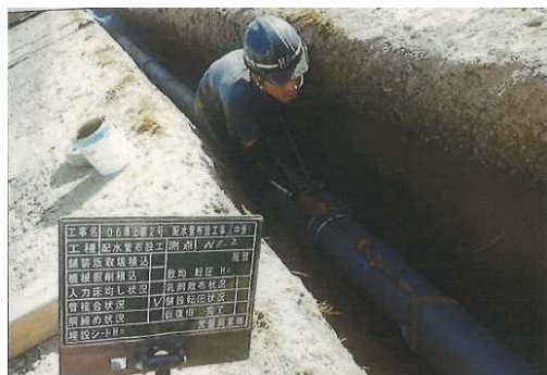
配水管布設工事
