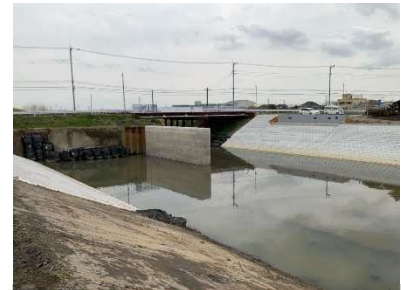
橋梁施設改修事業 （橋梁施設改修工事負担金）
