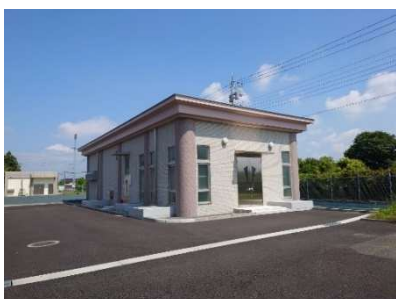
久保浄水場低区配水施設管理棟新設
