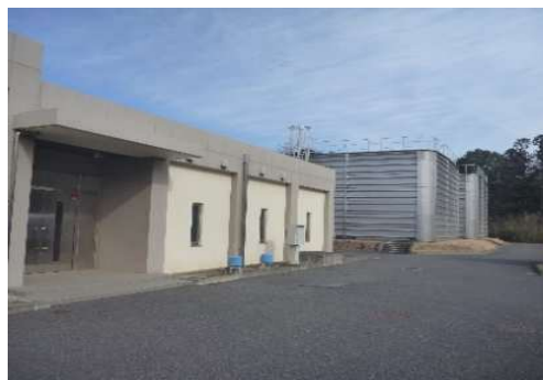
みらい平配水場
