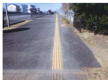
施設維持補修事業 （紫峰ヶ丘・歩道補修工事）
