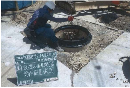
マンホール蓋交換工事 (受枠設置)
