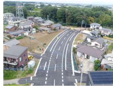
守谷小絹線整備事業 (筒戸・道路新設改良工事)
