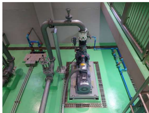
みらい平配水場配水ポンプ増設
