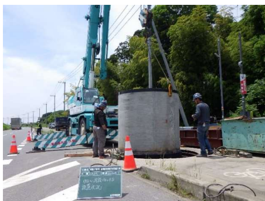
污水管布設工事
