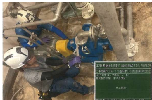
真空ポンプ修繕工事（据付）
