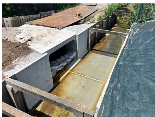
雨水放流渠布設工事
