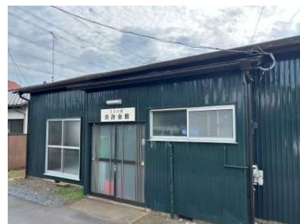
集会施設整備補助金を活用して補修を行った勘兵衛新田 5 期行政区の集会施設
