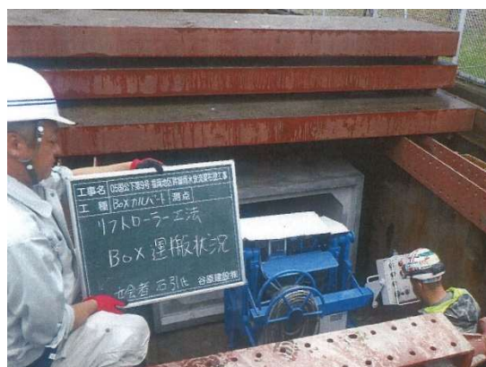
雨水放流渠布設工事
