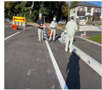
建設工事の竣工検査
