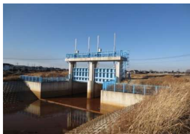
蛇沼排水路樋管
