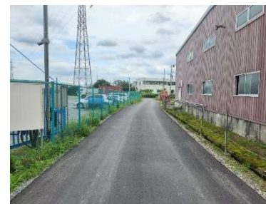
道路改良事業 (台・道路新設改良工事)
