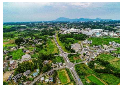
東櫛戸台線整備事業 （台・道路新設改良工事）
