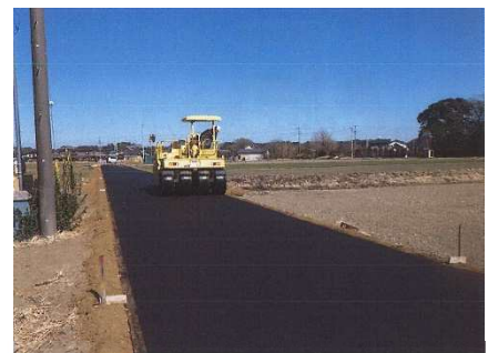
農道整備事業（福原・農道新設改良工事）
