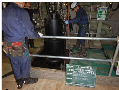
No.1主ポンプ修繕工事（据付）
