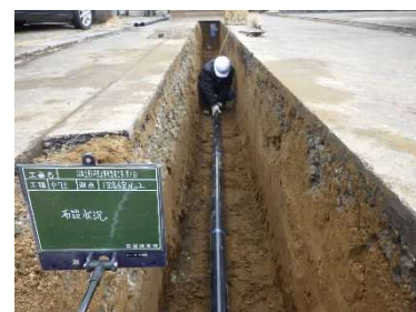
配水管布設替工事
