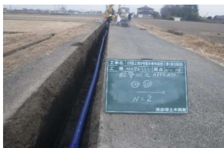
配水管布設替工事
