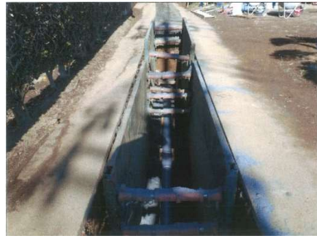
汚水管布設工事 (南)
