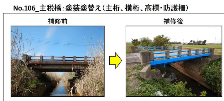
写真 1.1 補修状況写真
