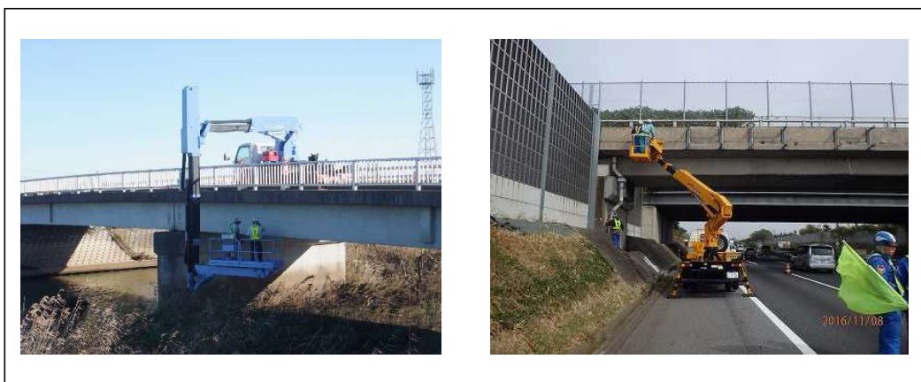
写真 4.1 定期点検状況
