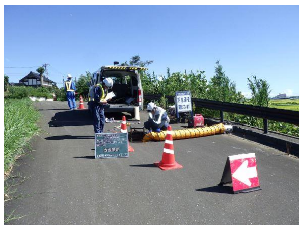
<下水道点検作業>
