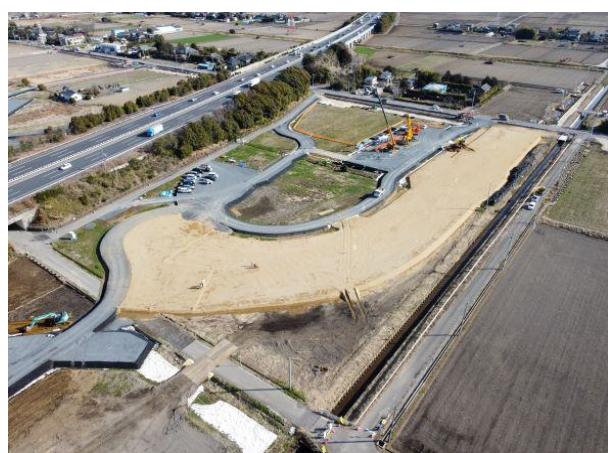
<スマートインターチェンジ整備工事>
