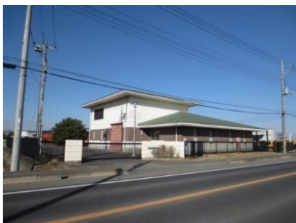
上小目中継ポンプ場
