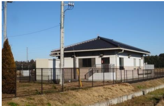
⑦高岡狸穴処理場
