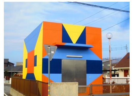
内宿中継ポンプ場
