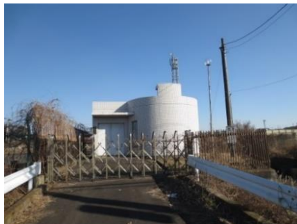
高掛中継ポンプ場
