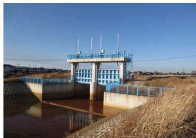
蛇沼排水路樋管
