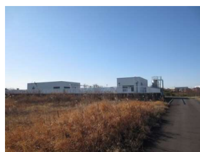
小絹水処理センター水処理棟
