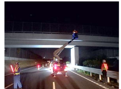
橋梁長寿命化修繕事業 （原山橋・橋梁定期点検業務委託料）
