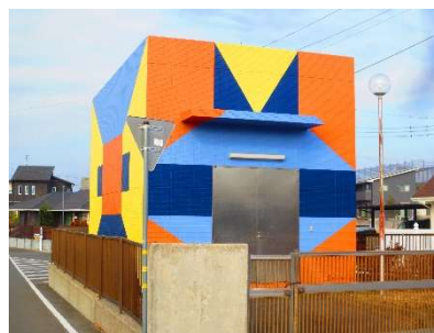
内宿中継ポンプ場
