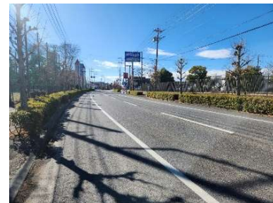
道路ストック点検補修事業 （ふれあい道路・舗装補修工事）
