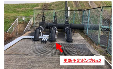
排水機場及び樋管管理事業 （西ノ台地区調整池・四ヶ字入 排水機場ポンプ更新工事）
