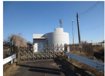
高掛中継ポンプ場
