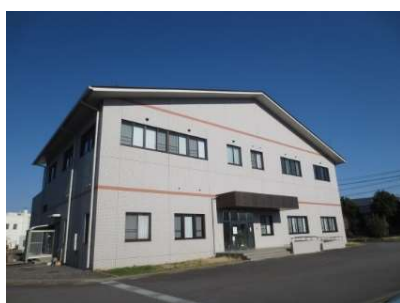
小絹水処理センター管理棟
