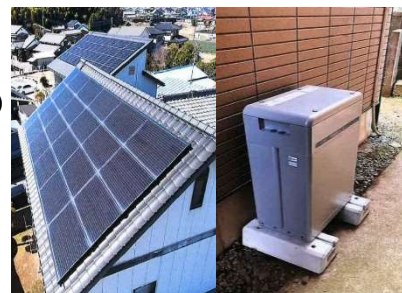
太陽光発電設備と接続する蓄電システム
