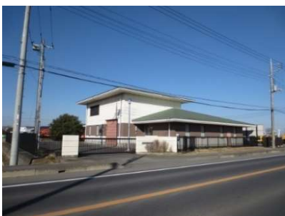
上小目中継ポンプ場
