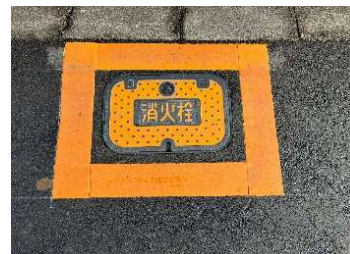
消防施設表示補修工事
