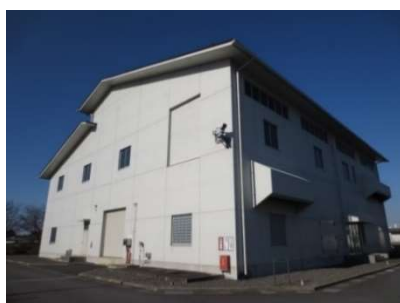
小絹水処理センター汚泥棟
