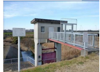
大谷津排水樋管
