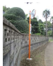
道路反射鏡設置状況
