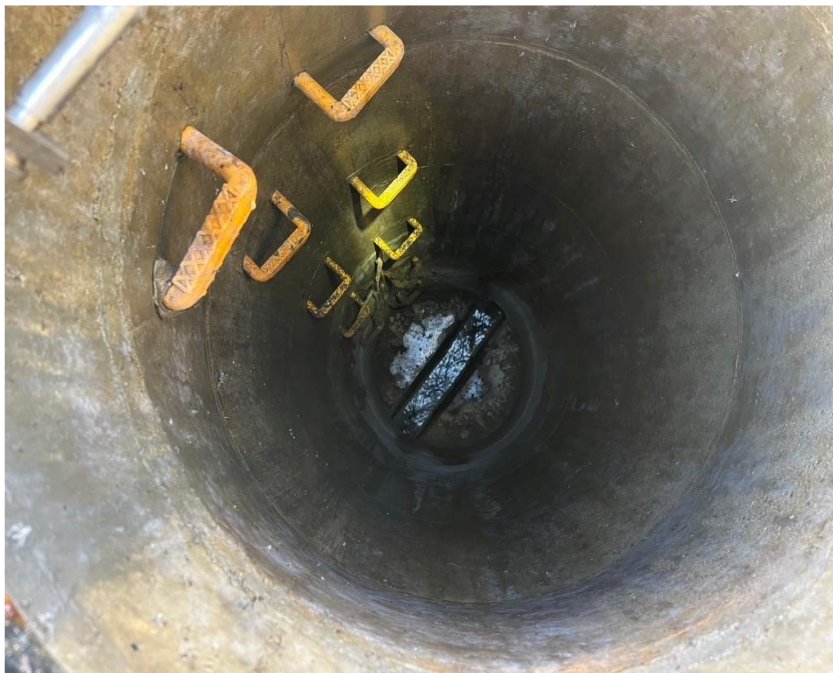
マンホール内の確認状況
