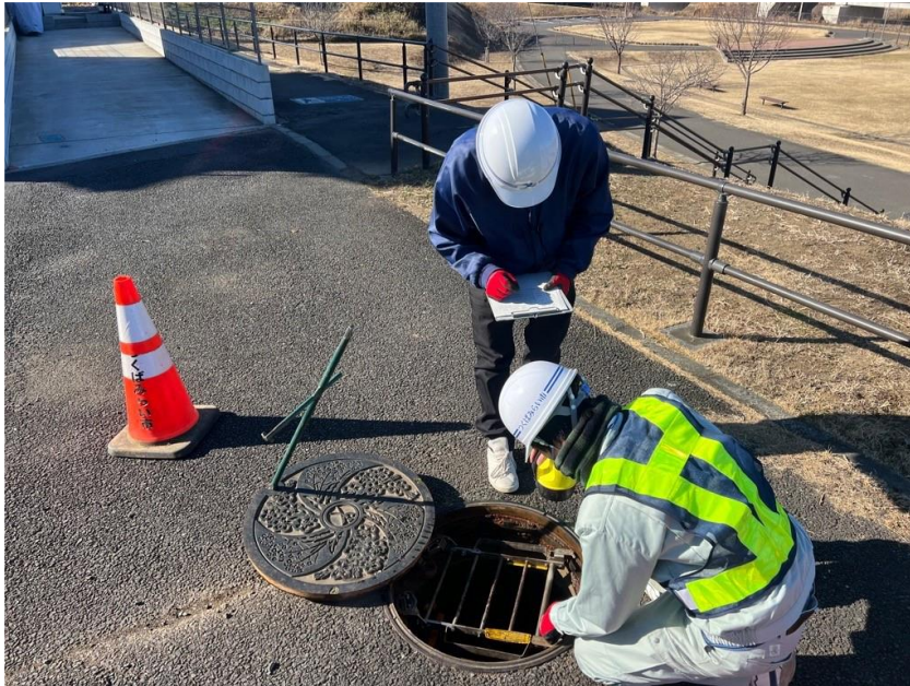
マンホール内の点検状況
