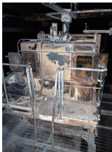
No.1 破砕物搬送コンベア
