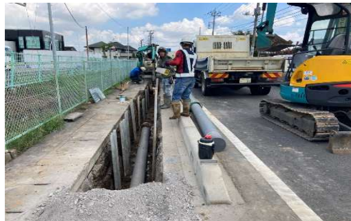
配水管布設工事
