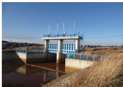
蛇沼排水路樋管
