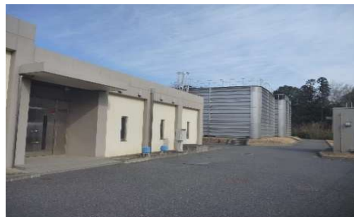
みらい平配水場
