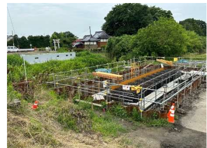
橋梁施設改修事業 （橋梁施設改修工事負担金）
