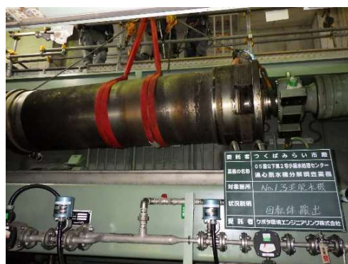
遠心脱水機修繕工事
