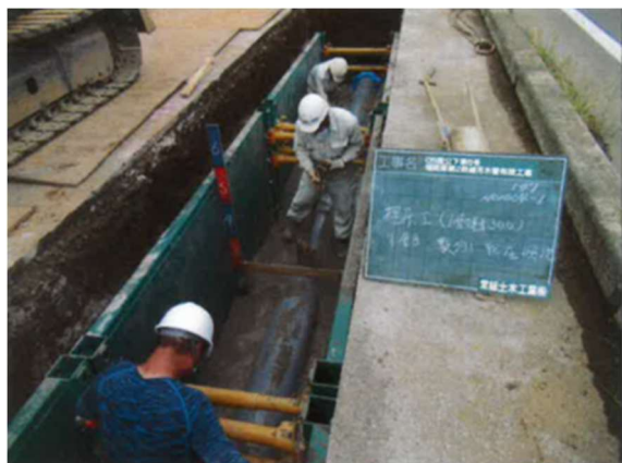
污水管布設工事
