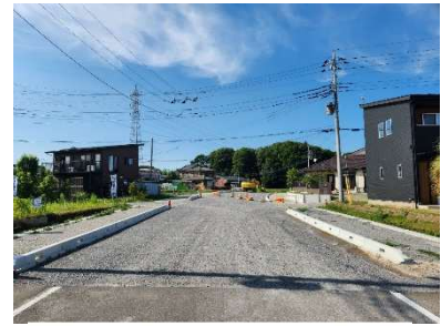
守谷小絹線整備事業 （筒戸・道路新設改良工事）
