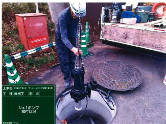
マンホールポンプ設置工事
