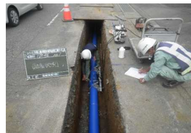
配水管布設替工事
