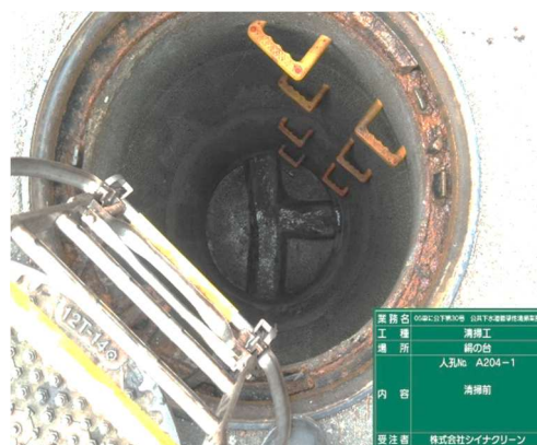
汚水管清掃状況
