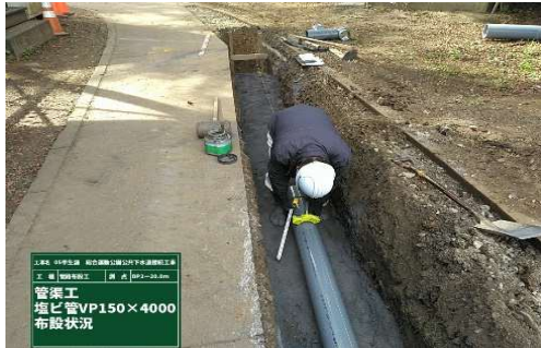
総合運動公園公共下水道接続工事
