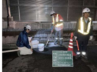
配水管洗浄作業
