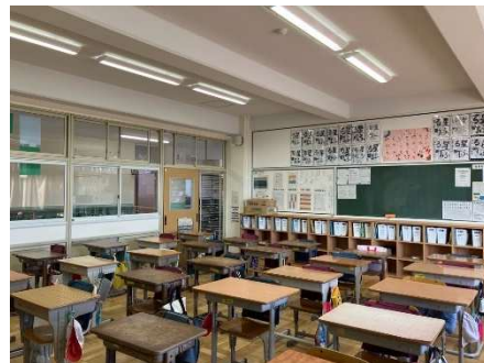
小絹小学校大規模改修工事後の内見
