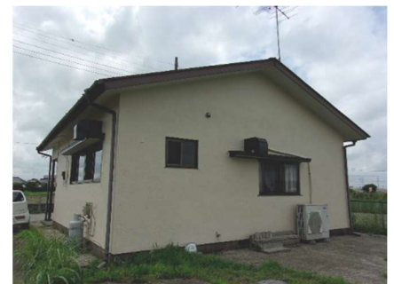
集会施設整備補助金を活用して補修 を行った中曽根行政区の集会施設
