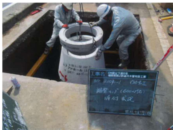
マンホール設置工事
