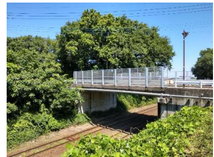
橋梁長寿命化修繕事業 （小絹・橋梁補修工事）
