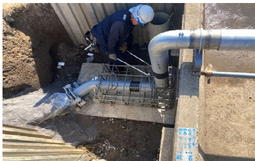
配水管布設替工事
