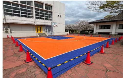
バスケットボールコート整備工事
