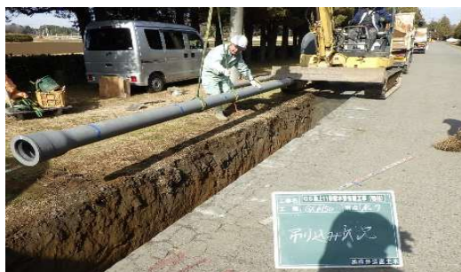
配水管布設工事
