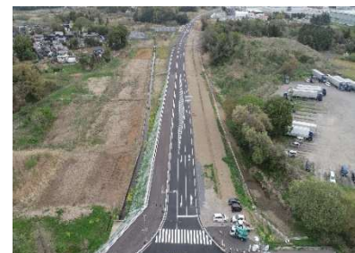
東檜戸台線整備事業 （台・道路新設改良工事）
