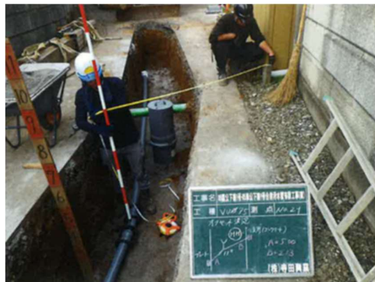
汚水管布設工事(圧送管)
