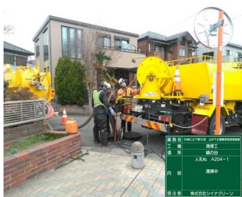
汚水管清掃作業
