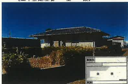
《上平柳処理場 全 景》
