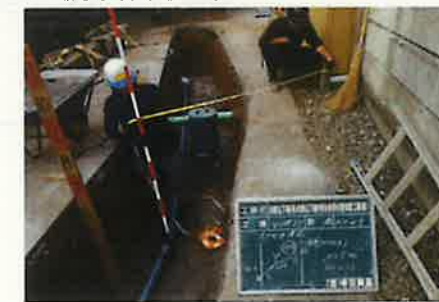
《汚水管布設工事(圧送管)》
