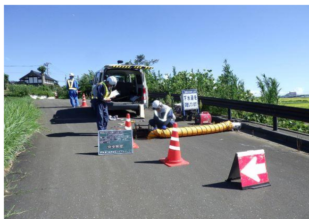
<下水道点検作業>
