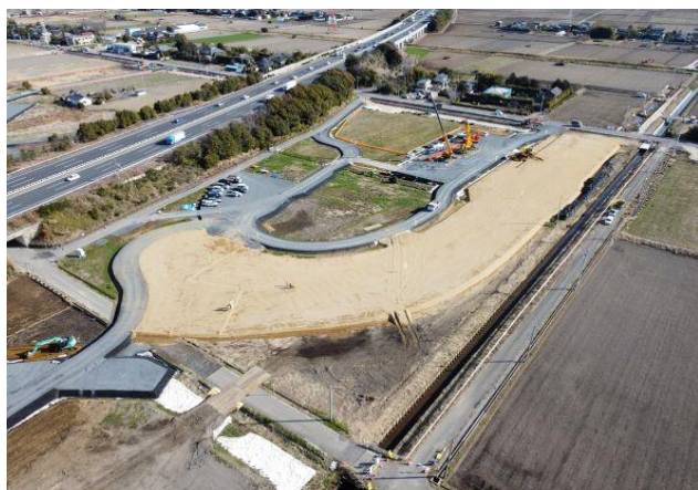
<スマートインターチェンジ整備工事>
