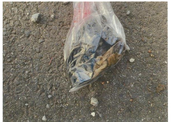
写真1 ポンプ分解による異物（男性用下着）状況
