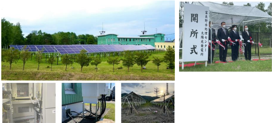
出典) 株式会社フソウ・エナジー「富良野水処理センター太陽光発電所 7月14日(木)より稼働」(2022.6) 株式会社NEBEC ブログ「富良野市 公共施設 自家消費型太陽光発電②」(2022.5) より抜粋
