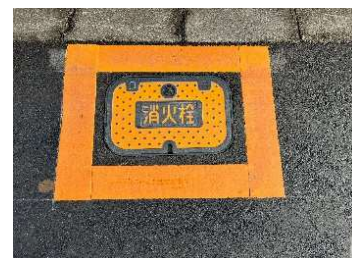
消防施設表示補修工事
