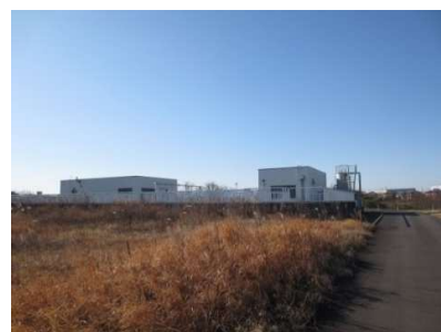
小絹水処理センター水処理棟
