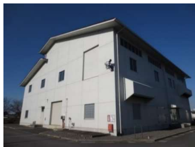
小絹水処理センター汚泥棟
