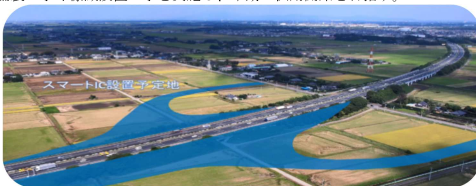
スマートインターチェンジ設置予定地
