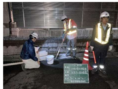
配水管洗浄作業
