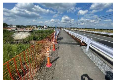
橋梁施設改修事業 (福新橋・橋梁施設改修工事負担金)
