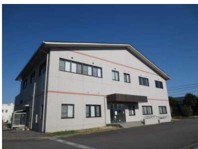
小絹水処理センター管理棟
