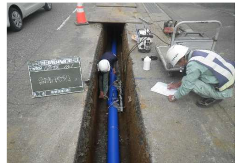
配水管布設替工事
