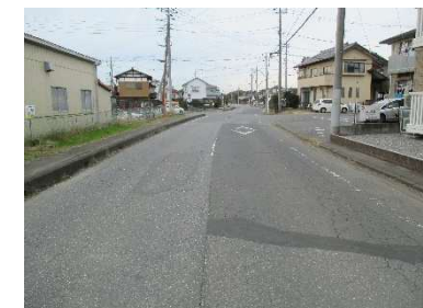
道路ストック点検補修事業 （伊奈東・舗装補修工事）
