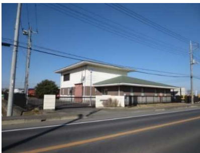
上小目中継ポンプ場
