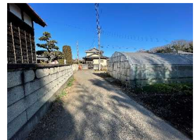
市道冠水対策事業 （鬼長・維持補修工事）
