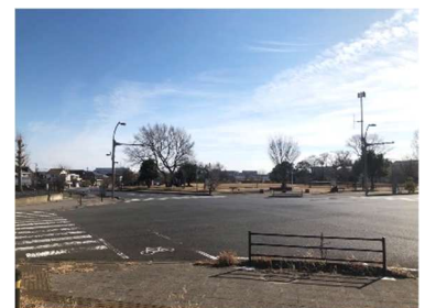
道路安全対策事業 （富士見ヶ丘・通学路安全対策工事）
