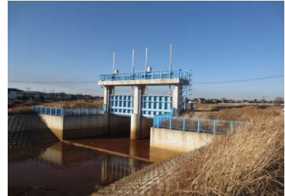
蛇沼排水路樋管
