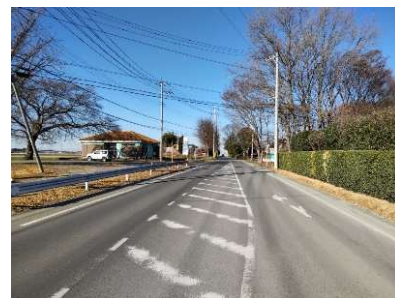
中原線整備事業 (中原・測量業務委託料)
