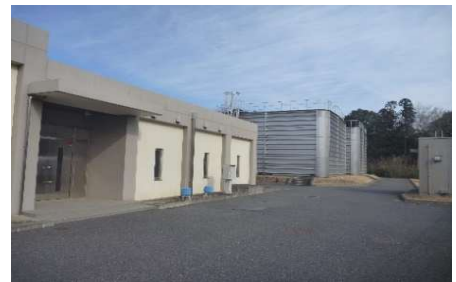
みらい平配水場
