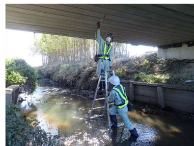
橋梁長寿命化修繕事業 (55橋・橋梁定期点検業務委託料)
