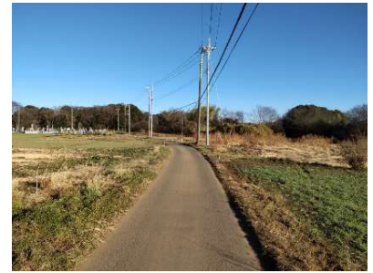
狭あい道路整備等促進事業 （戸茂・道路新設改良工事）
