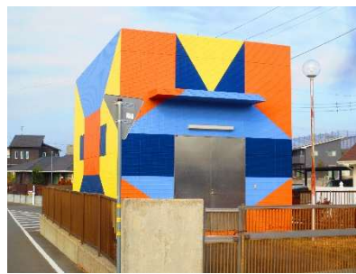
内宿中継ポンプ場
