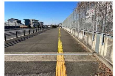
施設維持補修事業 （みらい平・歩道補修工事）
