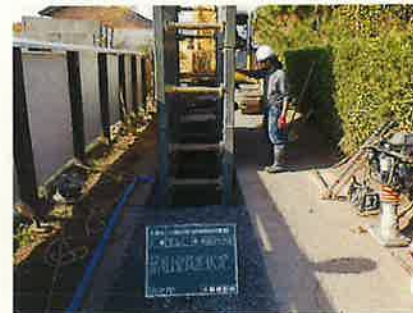
【汚水管布設工事(南)】
