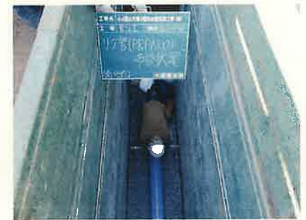
【汚水管布設工事(南)】
