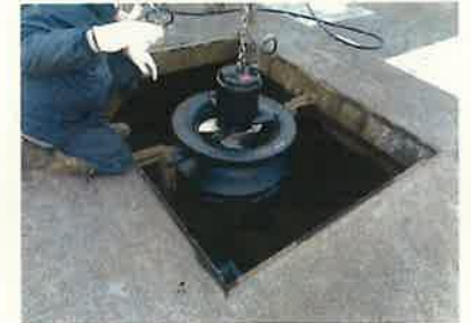
【下小目処理場ばっ気攪拌装置交換工事】
