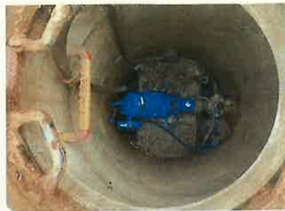
【下小目地区真空弁ユニット交換】
