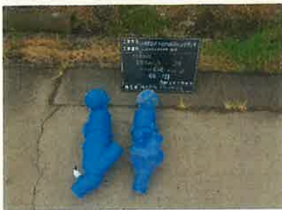
【下小目地区真空弁ユニット交換】
