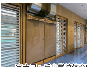
富士見ヶ丘小学校体育館に 空調換気システムの設置
