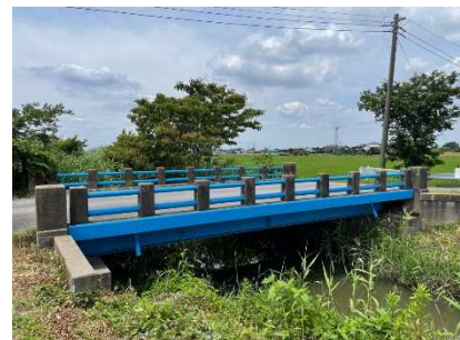
橋梁長寿命化修繕事業 (山王新田・橋梁補修工事)
