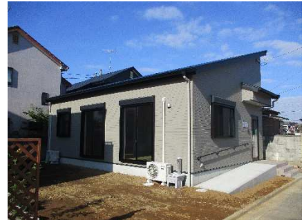
コミュニティ助成事業補助金を活用して建設を行った松葉台自治会の集会施設
