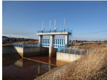
蛇沼排水路樋管
