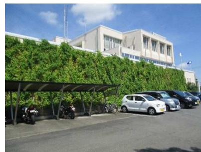
谷和原庁舎に設置した緑のカーテン
