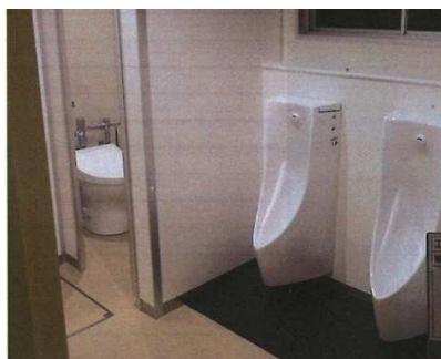
福岡小学校トイレ改修工事
