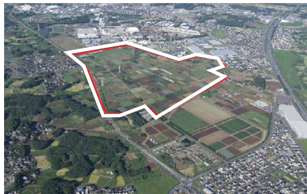
福岡工業団地第2期地区 団地名称：圏央道インターパーク つくばみらい
