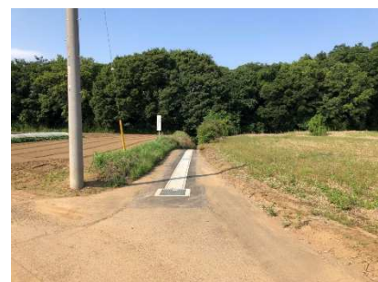
狭あい道路整備等促進事業 (戸茂・排水整備工事)
