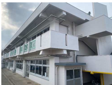
小絹小学校大規模改修工事後の外観
