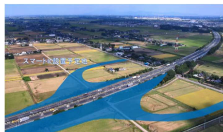
スマートインターチェンジ設置予定地
