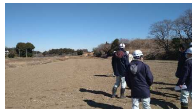
建設工事の竣工検査
