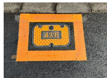
消防施設表示補修工事
