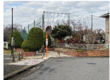
カーブミラー設置状況
