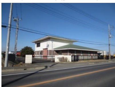
上小目中継ポンプ場
