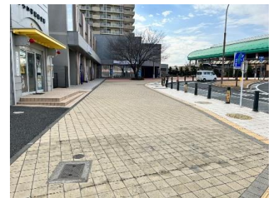
施設維持補修事業 （みらい平駅前歩道・歩道補修工事）
