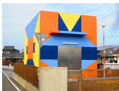
内宿中継ポンプ場
