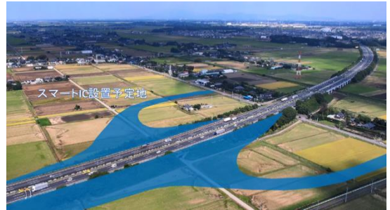
スマートインターチェンジ設置予定地
