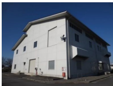
小絹水処理センター汚泥棟
