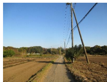
狭あい道路整備等促進事業 （戸茂・電柱移転補償費）
