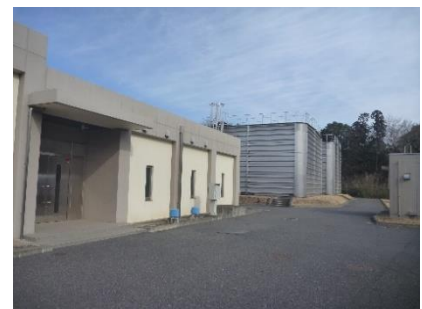
みらい平配水場
