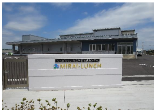
学校給食センター（外観）
