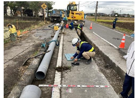
耐震管布設工事
