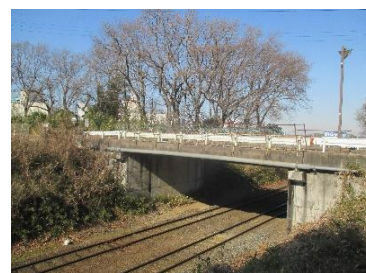
橋梁長寿命化修繕事業 （西ノ台・橋梁補修工事）
