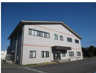
小絹水処理センター管理棟
