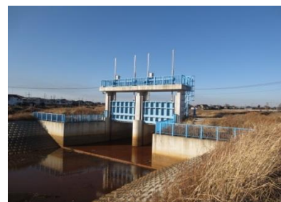
蛇沼排水路樋管
