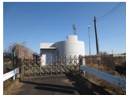
高掛中継ポンプ場
