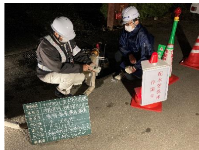
配水管洗浄作業
