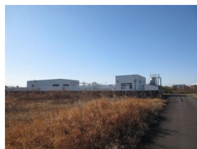
小絹水処理センター水処理棟
