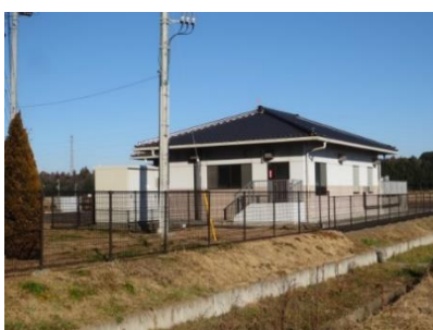
高岡狸穴処理場
