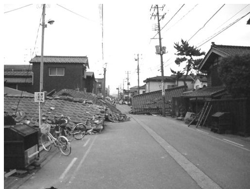
▲新潟県中越沖地震による住宅の倒壊
