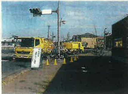
《清掃作業状況》
