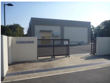
みらい平配水場
