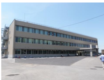
つくばみらい市役所 伊奈庁舎(新)
