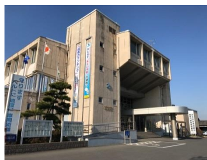
つくばみらい市役所 谷和原庁舎
