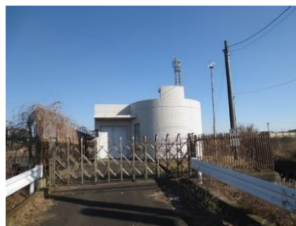
高掛中継ポンプ場
