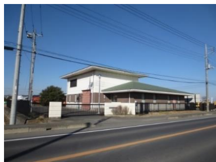
上小目中継ポンプ場
