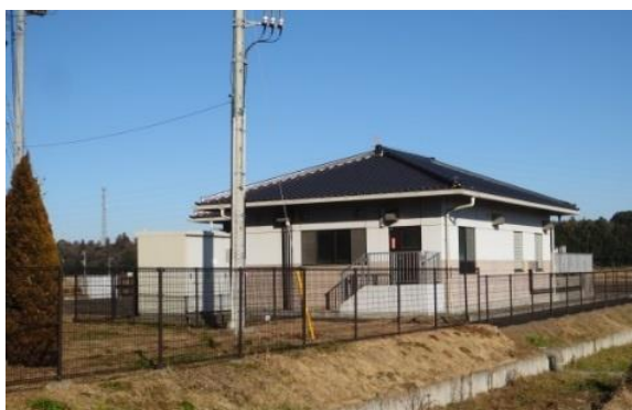
⑦高岡狸穴処理場
