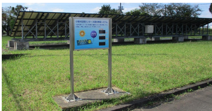
図 2-1-4-1. 小絹水処理センター太陽光発電システム
