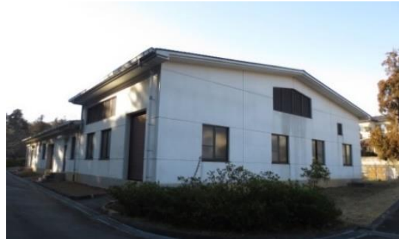
狸穴住宅地区コミュニティ・プラント
