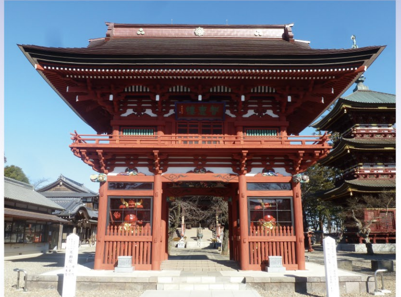
不動院楼門（県指定文化財）昭和49年11月25日指定
