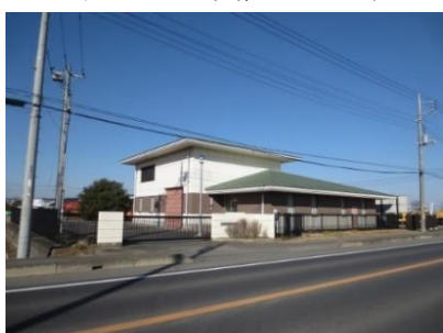
上小目中継ポンプ場
