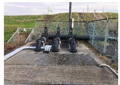
排水機場及び樋管管理事業 （杉下・四ヶ字入排水機場ポンプ更新工事）
