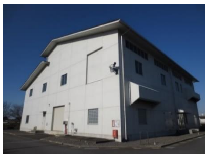
小絹水処理センター汚泥棟
