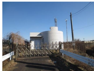
高掛中継ポンプ場
