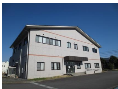
小絹水処理センター管理棟
