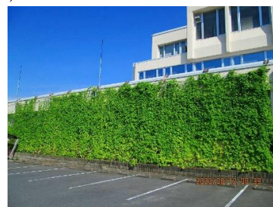
谷和原庁舎に設置した 緑のカーテンの様子
