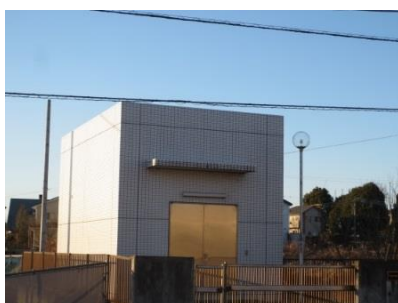
内宿中継ポンプ場
