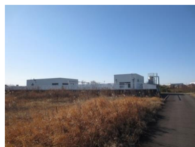
小絹水処理センター水処理棟
