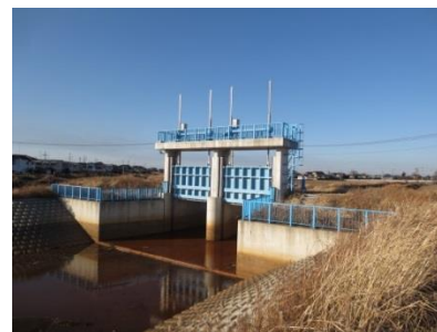
蛇沼排水路樋管
