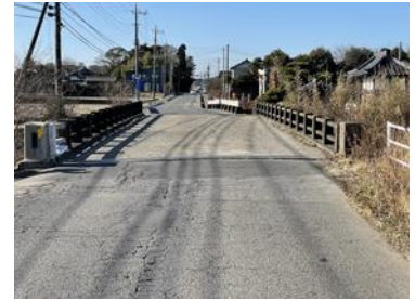
橋梁施設改修事業 （福田・福新橋）
