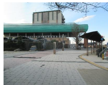
施設維持補修事業 （みらい平駅前歩道・舗装補修工事）
