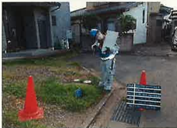
《作業状況》 (給水管漏水調査)
