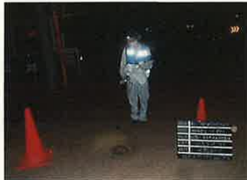
《作業状況》 (水道本管漏水調査)
