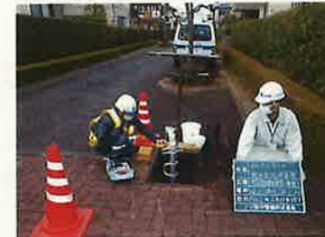
《作業状況》 (事後、配水管内を水中カメラにより確認)
