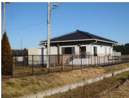
高岡狸穴処理場
