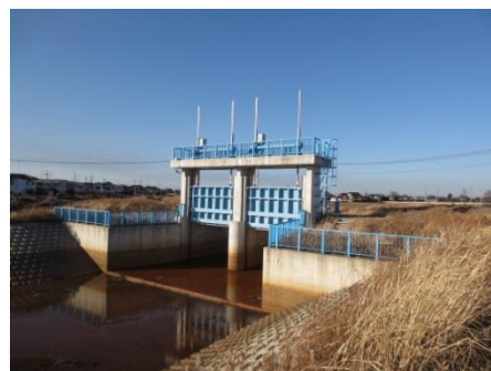
蛇沼排水路樋管
