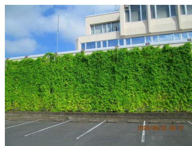
谷和原庁舎に設置した緑のカーテン
