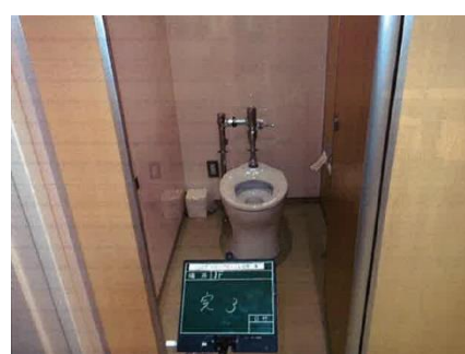
谷原小学校トイレ改修工事（女子トイレ）
