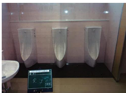
谷原小学校トイレ改修工事（男子トイレ）
