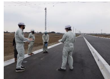
建設工事の竣工検査
