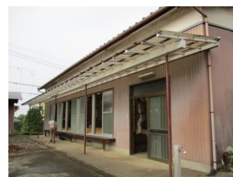
修繕を行った 愛宕行政区の集会施設
