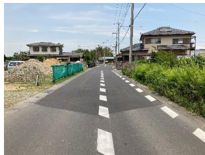
道路ストック点検補修事業（狸渕）
