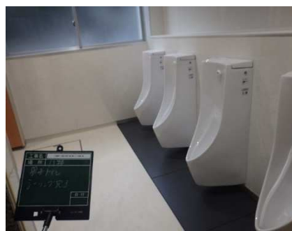
小絹小学校 19 棟トイレ改修工事
