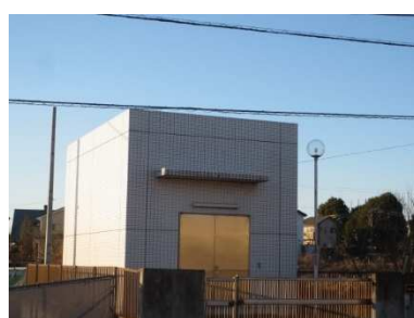
内宿中継ポンプ場
