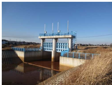
蛇沼排水路樋管
