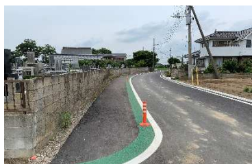
道路改良工事 (豊小区)
