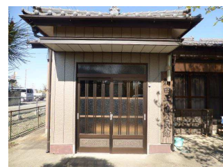
修繕を行った 新田正角地区の集会施設
