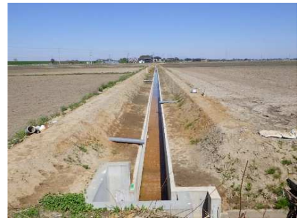
改修された排水路
