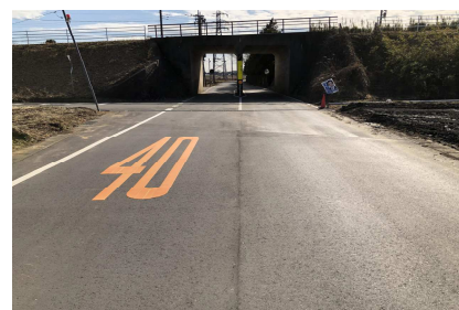
道路ストック点検補修事業 (狸淵)
