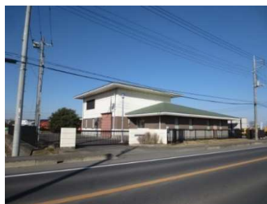
上小目中継ポンプ場
