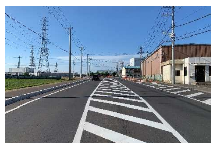
道路新設改良工事（坂野新田交差点改良）
