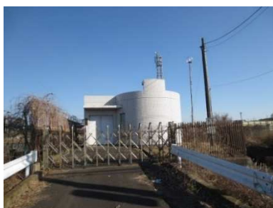
高掛中継ポンプ場
