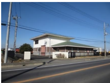
上小目中継ポンプ場
