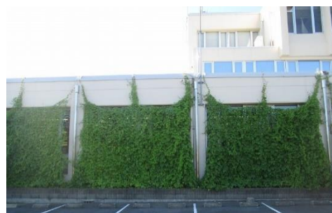
谷和原庁舎に設置した緑のカーテン
