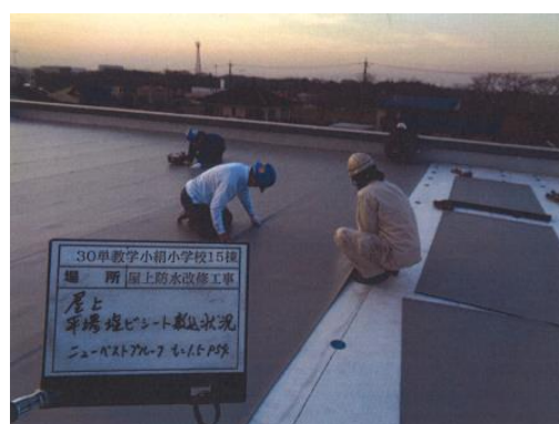
小絹小学校屋上防水改修工事
