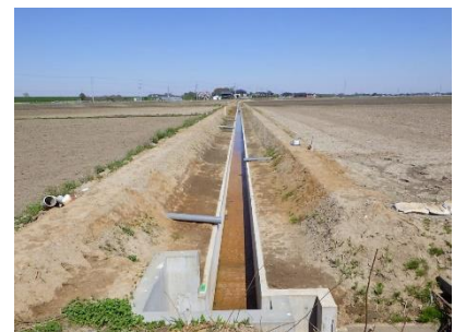
改修された排水路
