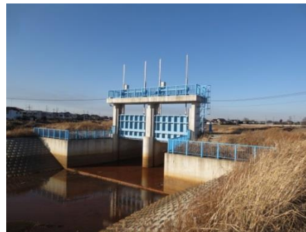
蛇沼排水路樋管
