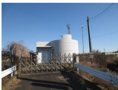
高掛中継ポンプ場
