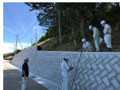
建設工事の竣工検査風景
