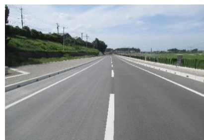
守谷・小絹線整備
