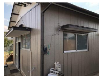
修繕を行った寺町公民館
