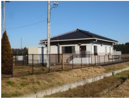
高岡狸穴処理場
