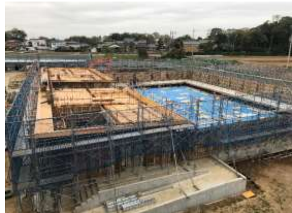
富士見ヶ丘小学校建設状況（プール棟）
