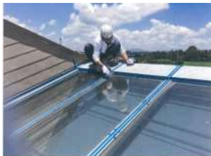
シーリング打ち替え工事
