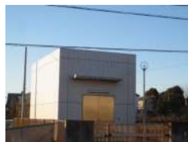
内宿中継ポンプ場
