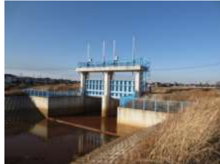
蛇沼排水路樋管
