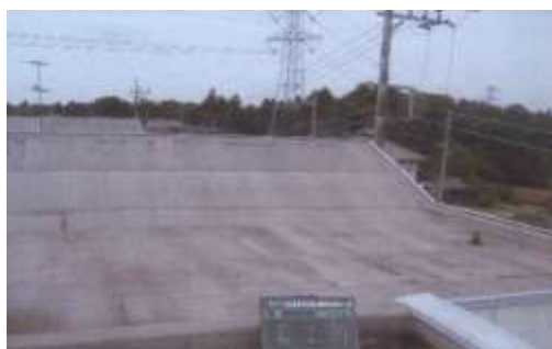
公営住宅屋根改修工事前
