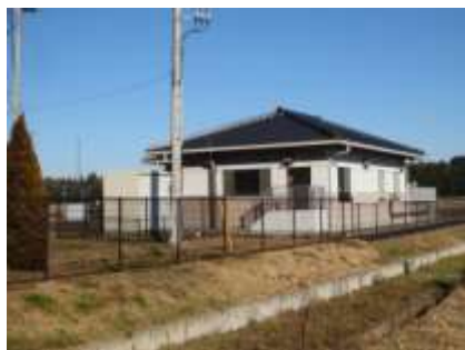
高岡狸穴処理場
