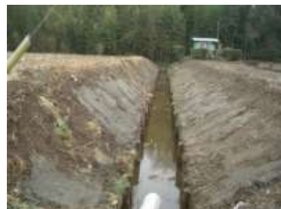
浚渫した排水路
