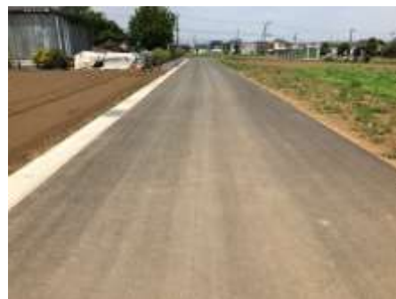
西榑戸狭あい道路整備
