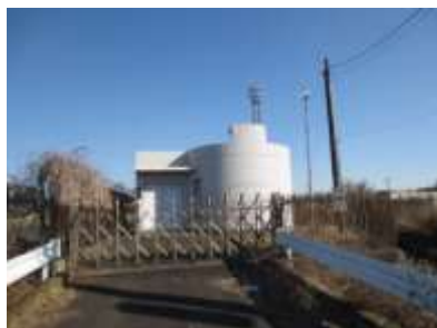
高掛中継ポンプ場
