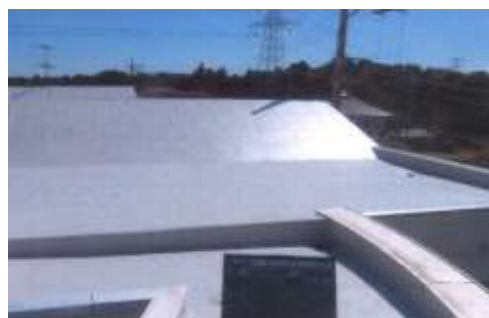
公営住宅屋根改修工事後
