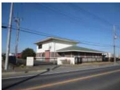
上小目中継ポンプ場
