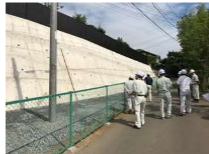
建設工事の竣工検査風景
