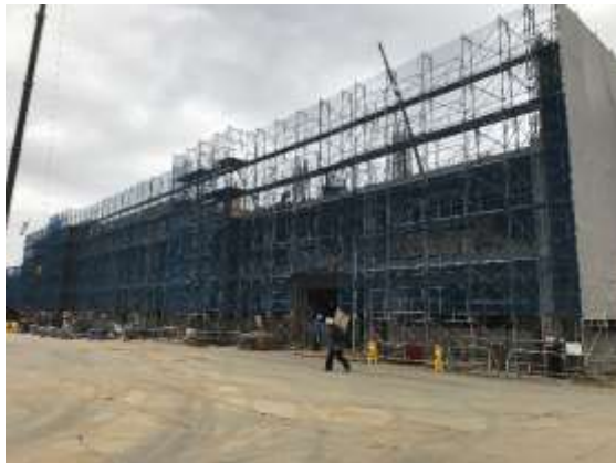
富士見ヶ丘小学校建設状況（校舎棟）
