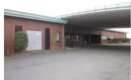
保健福祉センター外観
