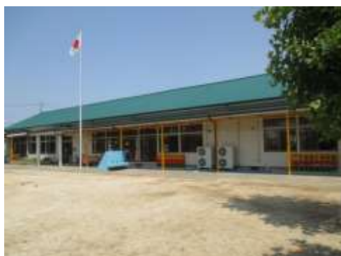
耐震補強等工事後の園舎
