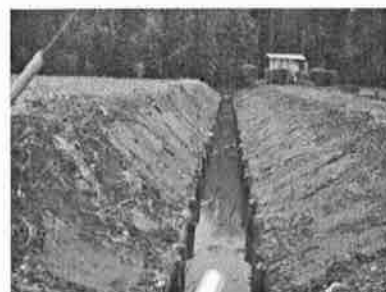
浚渫した排水路
