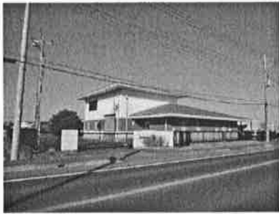
上小目中継ポンプ場
