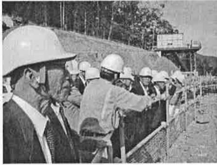
八ツ場ダムの工事現場視察
