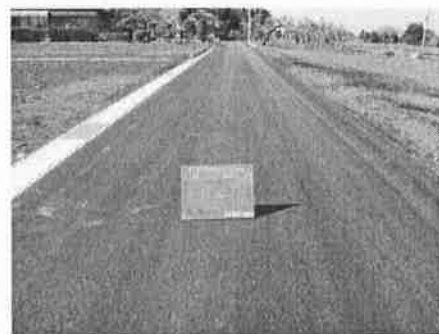
西檜戸狭あい道路整備
