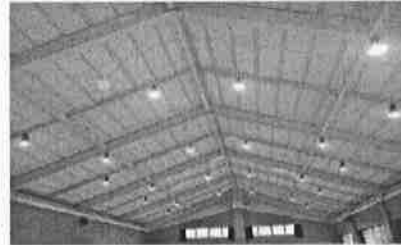
吊り天井改修工事後の小絹中学校柔剣道場
