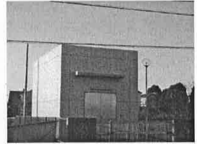
内宿中継ポンプ場
