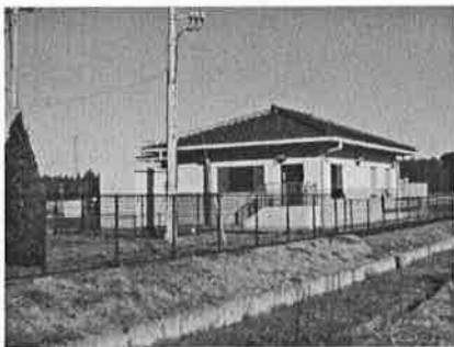
高岡狸穴処理場
