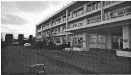
耐震・大規模工事後の伊奈中学校校舎
