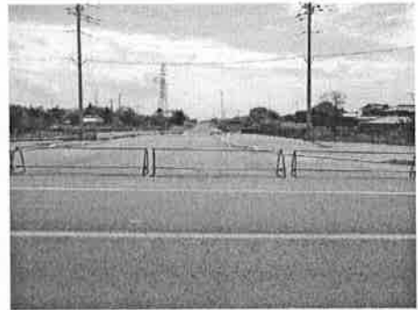
東楯戸台線整備
