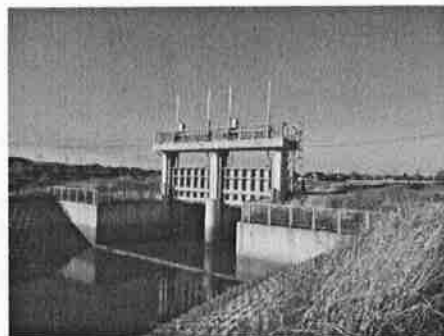
蛇沼排水路樋管
