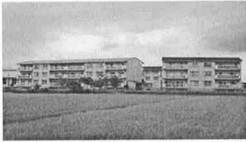
公営古川住宅
