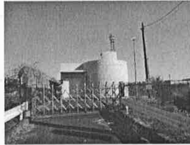
高掛中継ポンプ場
