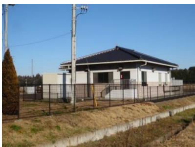
高岡狸穴処理場
