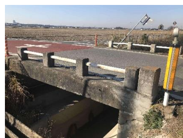
橋梁長寿命化修繕事業 （弥柳・橋梁維持補修工事）
