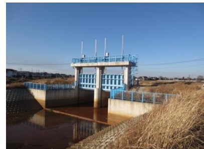
蛇沼排水路樋管
