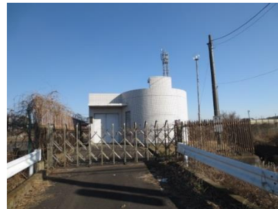
高掛中継ポンプ場
