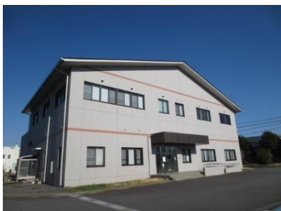
小絹水処理センター管理棟
