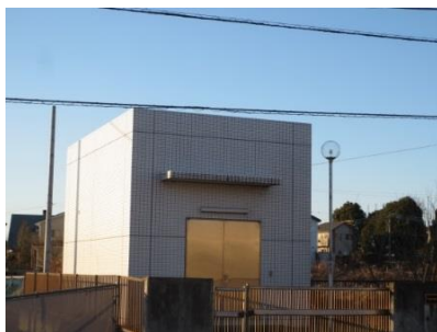
内宿中継ポンプ場
