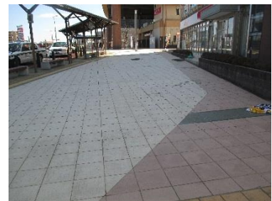
施設維持補修事業 （みらい平駅前歩道・舗装補修工事）
