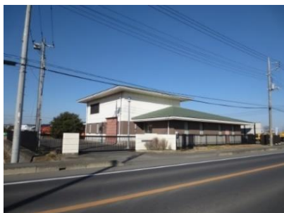
上小目中継ポンプ場
