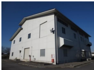
小絹水処理センター汚泥棟
