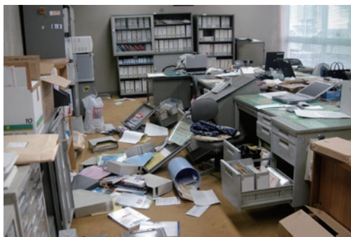
市庁舎も強い揺れにより大きな被害を受けた
