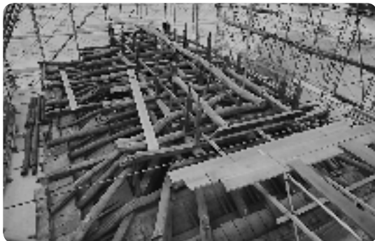
＜小屋組解体中の様子＞
