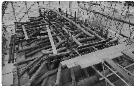
＜小屋組解体中の様子＞
