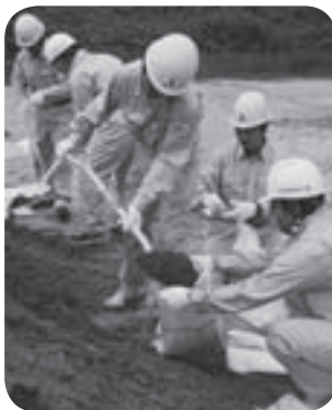
市水防隊員による土のうづくり
