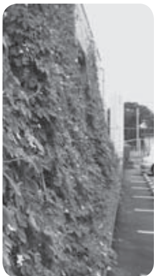
グリーンカーテンで覆われた市庁舎
