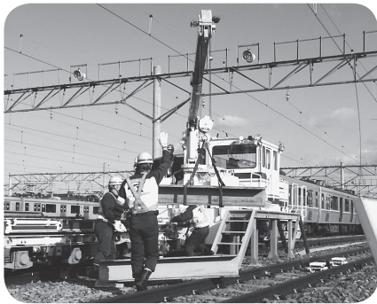
障害物をクレーンで撤去
