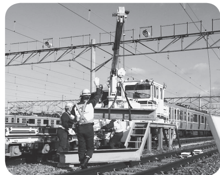
障害物をクレーンで撤去
