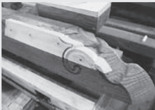
▷補修された部材
