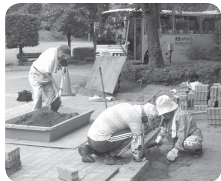
修復作業の様子
