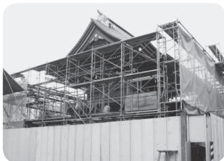
足場が解体される楼門
