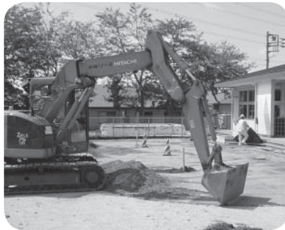
重機での除染作業の様子
