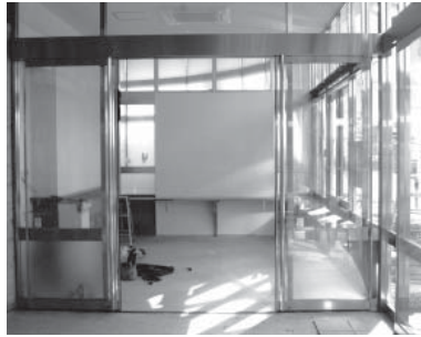
図書館改修工事の様子
