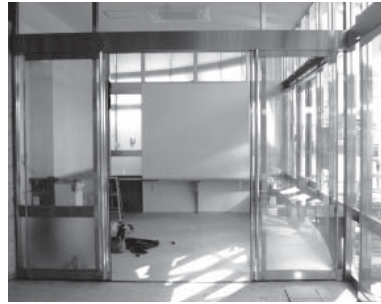
図書館改修工事の様子
