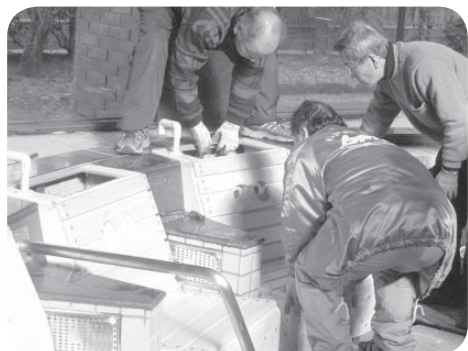
▷改修作業の様子
