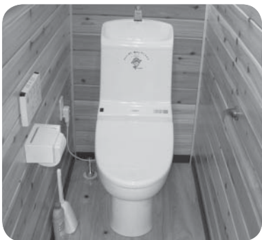
▷助成事業により改修された施設内トイレ
