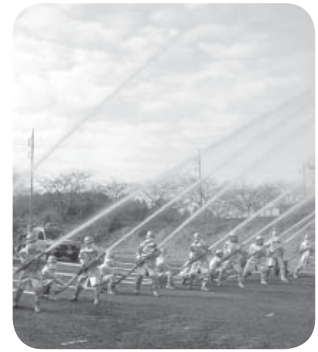
一斉放水の様子
